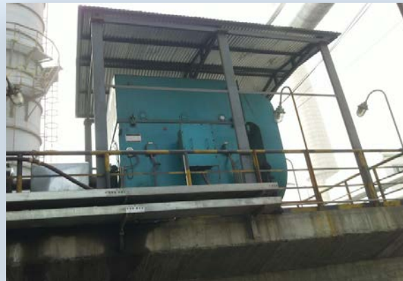
Двигатель для удаления пыли при спекании
