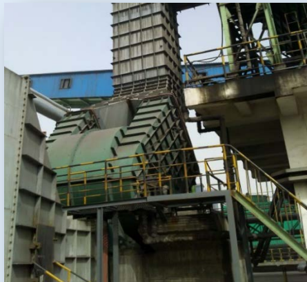
Вентилятор для удаления пыли при спекании
